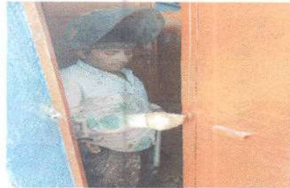
Foto 2: sustitucion de puertas en el baño
