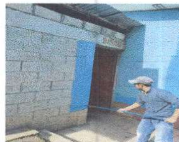
Foto 6: pintada de muros interiores y exteriores
