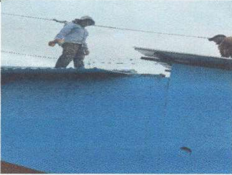
Foto1: Cambio de lamina sinc por lamina troquelada
