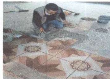
Foto 4: Sustitucion de Piso
